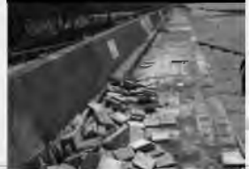
③ 護岸破損(チャンネルパーク)
