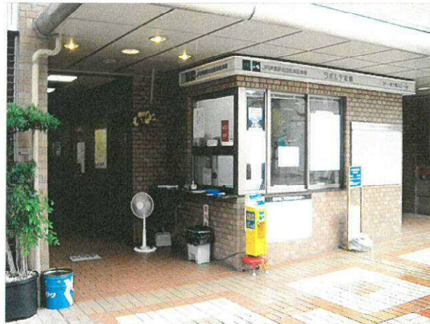
平成21年4月1日 兵庫県芦屋市 JR芦屋駅北自転車駐車場の管理を受託しました
