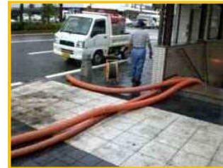
国道の側道に排水
