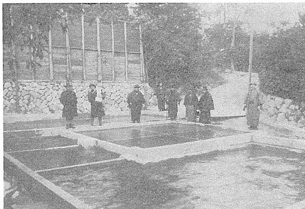
図270 山芦屋水道組合水源池（昭和初期）
