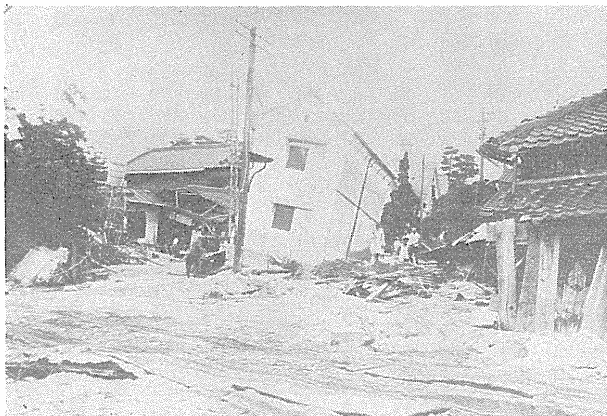
図272 昭和13年風水害による被害状況（国鉄芦屋駅北付近）
