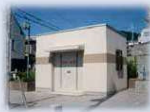
防災倉庫（三条南町）
