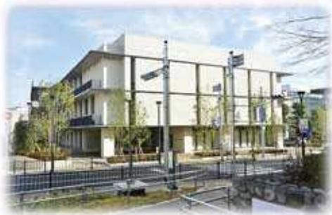
防災拠点となる芦屋市庁舎東館
