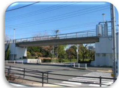
〔芦屋浜線歩道橋〕
