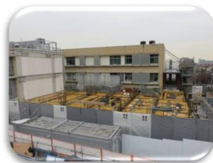
[岩園小学校の増築工事]
