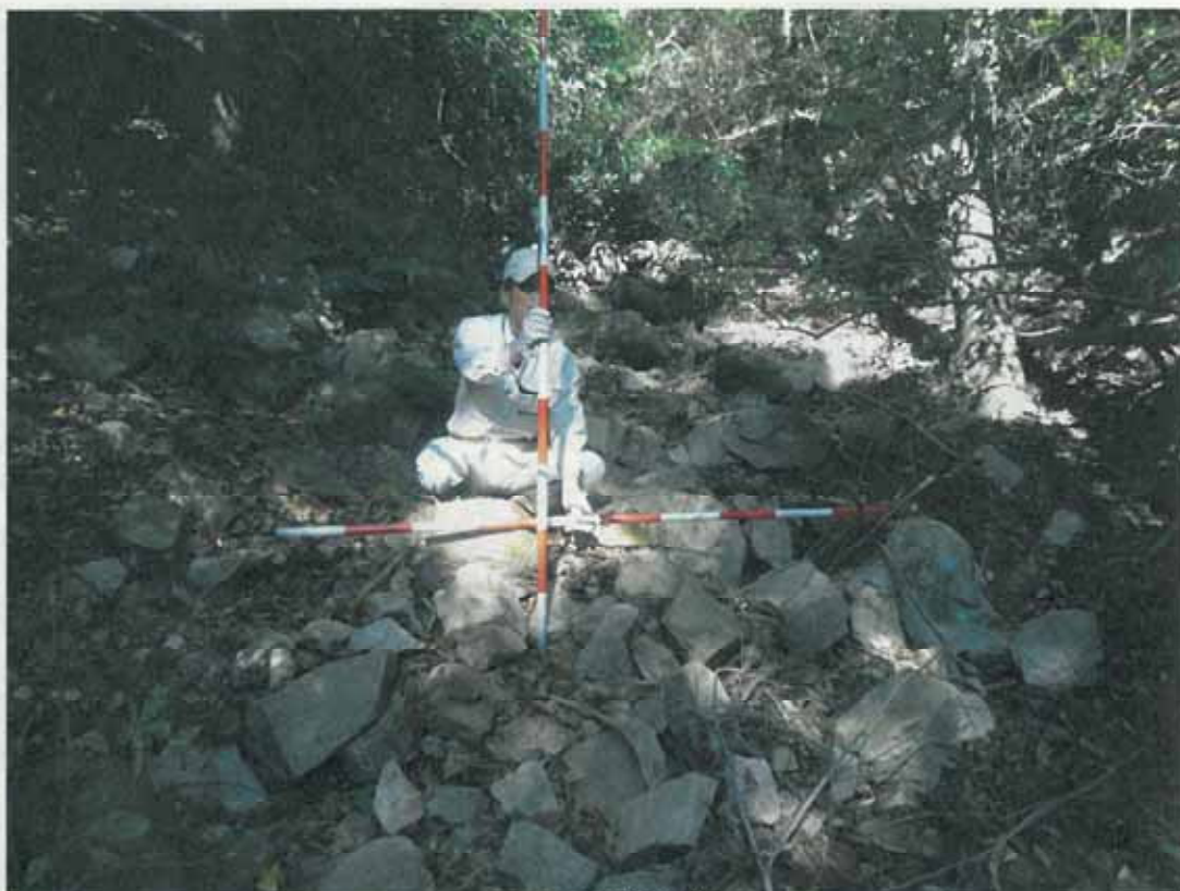
P1020620②荒廃状況
