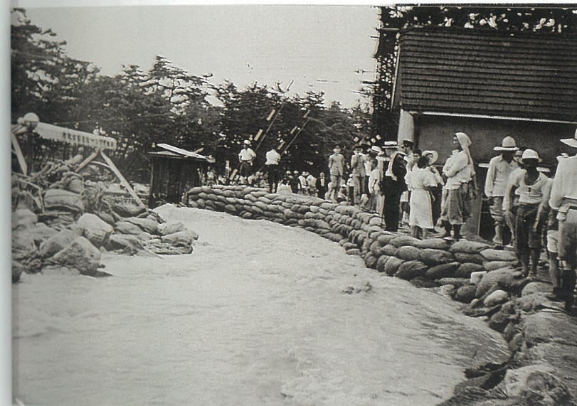
阪急芦屋川駅北側 土砂の流出を土のうを積んで防ぐ人びと。
