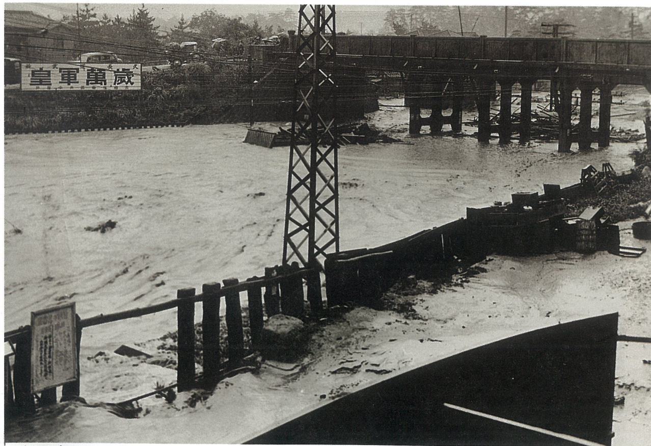
阪神大水害で泥水に埋まった国鉄線路 芦屋川をあふれた水は、芦屋駅の構内外にわたり、3万立方メートルもの大量の土砂を沈澱させ、その深さは3メートルにも及ぶ箇所もあり、線路は全く埋没してしまったと、大阪鉄道局の当時の記録に示されている。
