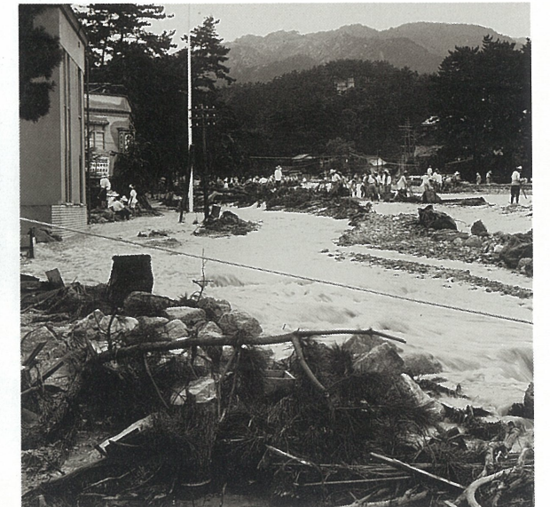
阪急芦屋川駅北側の惨状
