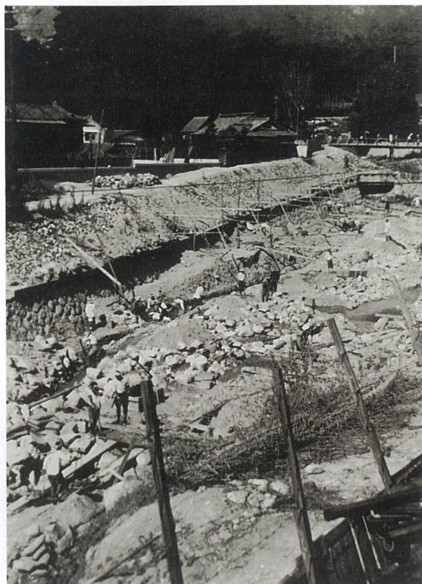
復旧工事 7月10日～30日まで、地元のほか、大阪、兵庫県下の学校、消防団、青年団など、延11,445人の勤労奉仕の協力があった。
