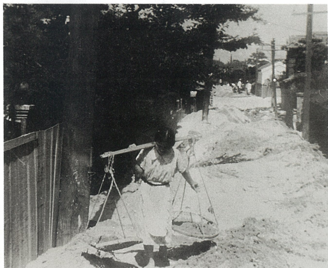
松ノ内町付近 河川の復旧工事は、昭和14年から7ヵ年かけて国の事業として行われ、多くの村民が復旧に協力した。
