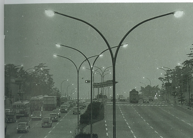
開通後の第2 阪神国道 昭和40年
