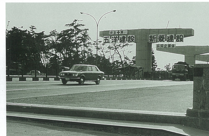
阪神高速道路建設工事 芦屋川橋付近
