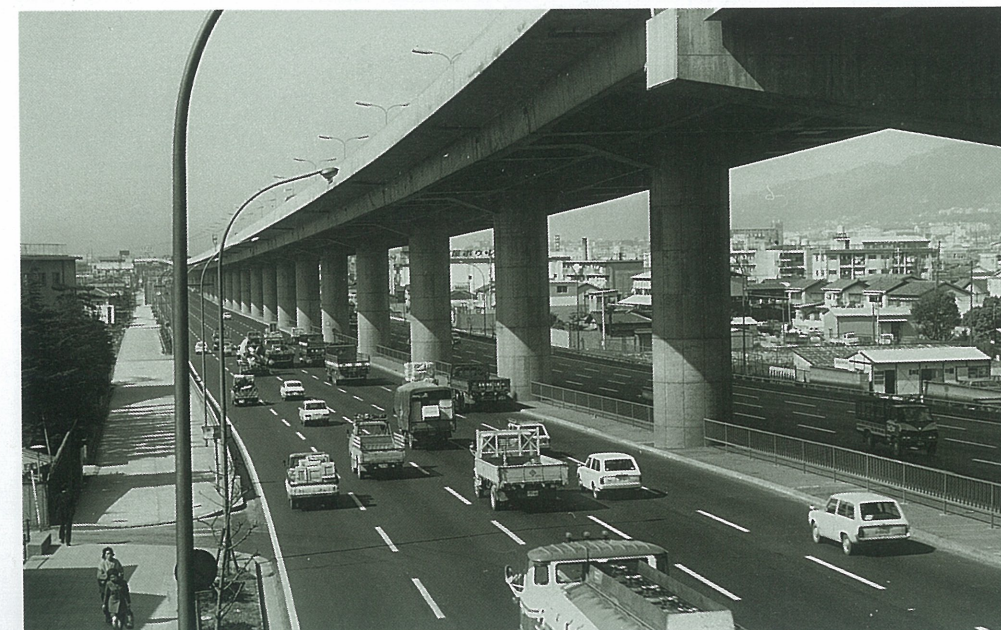
完成した兵庫県道高速神戸西宮線 昭和46年
