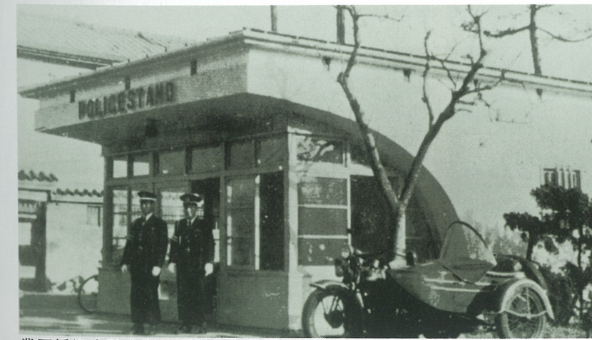
業平橋巡査駐在所 昭和25年設置
