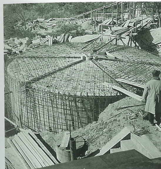
六麓荘水道施設工事 昭和32年4月
