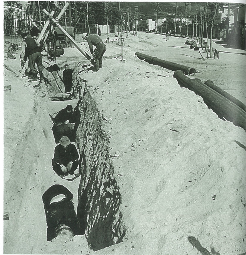
下水道工事 昭和33年
