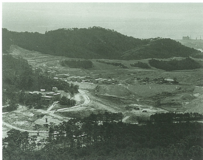
奥山貯水池をつくる工事 昭和44年
