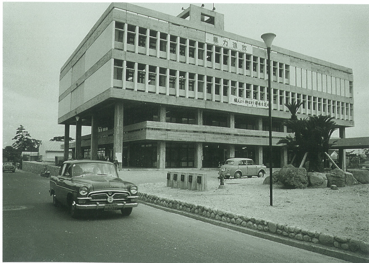
芦屋市市庁舎 昭和35年8月完成
