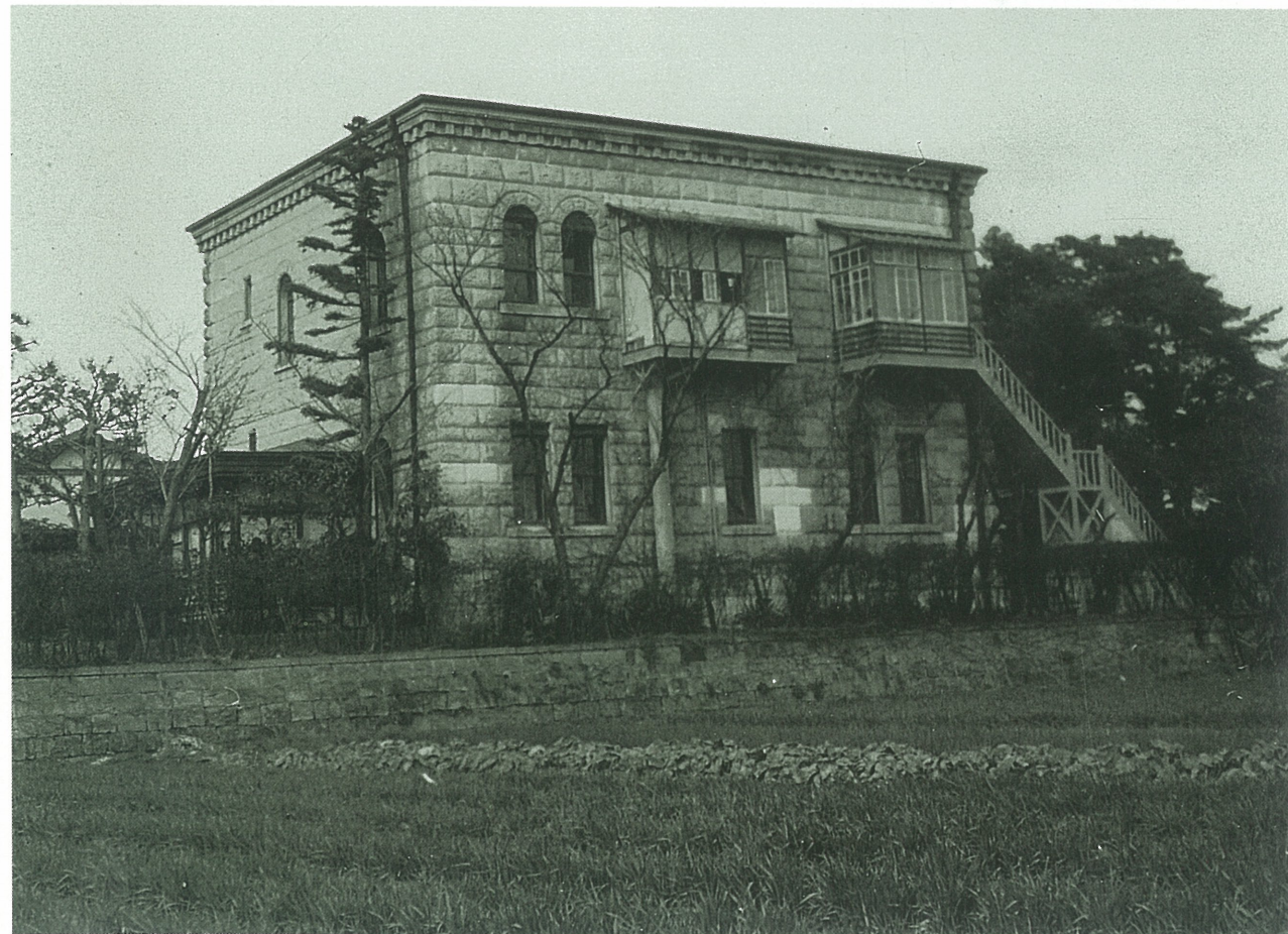
打出小槌町に移転した当時の旧図書館 現在、教育文化センターとして整備されつつある。
