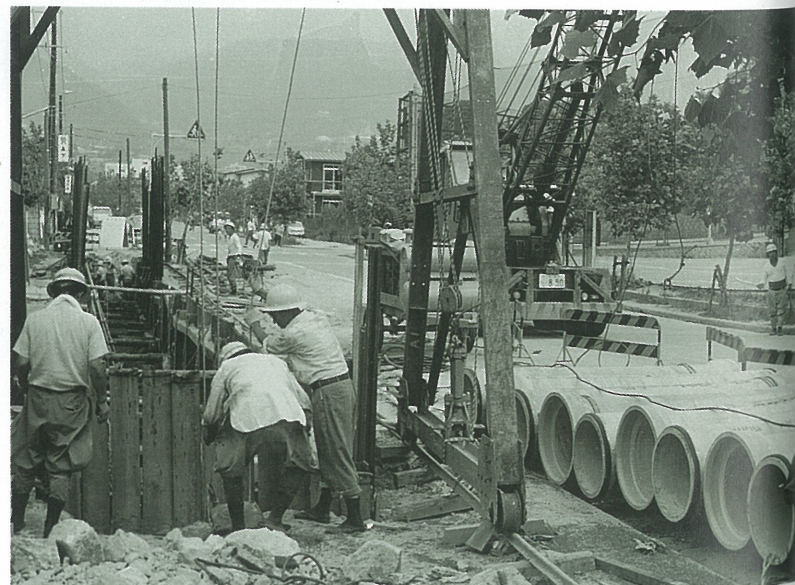
下水道工事(川西町) 昭和44年8月
