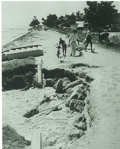
防潮堤の決壊 伊勢町付近、ジェーン台風による高潮によって東西150メートルにわたって決壊し、民家に大きな被害をもたらした。
