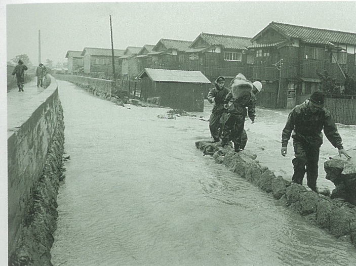
第2室戸台風で決壊した堀切川 昭和36年9月
