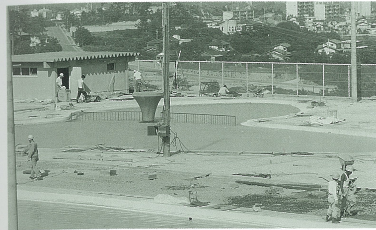
市民プール建設工事 昭和41年6月（朝日ヶ丘町）
