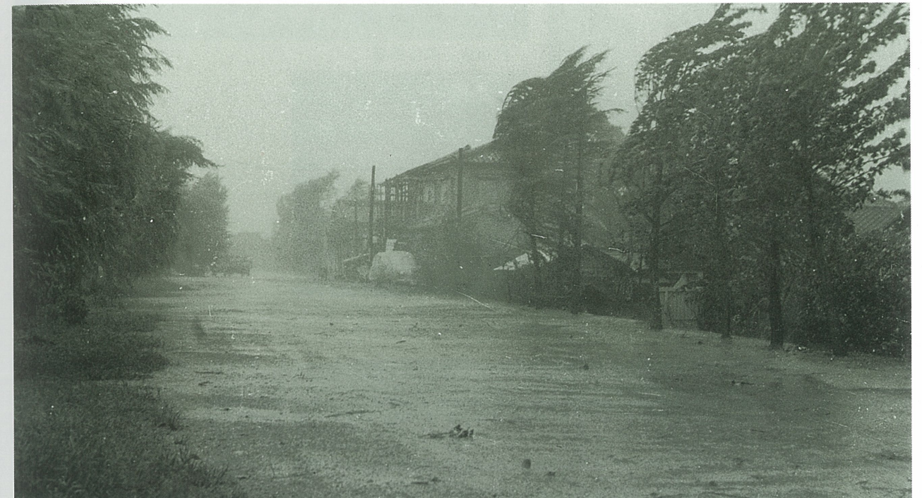
第2室戸台風 西蔵町海技大学校北側付近。中央の民家は撮影直後強風によって倒壊した。
