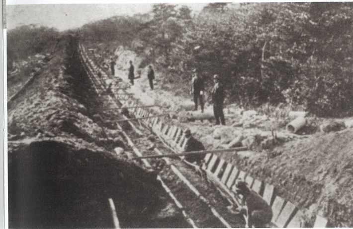
水道、ガス、電気地下埋設工事
