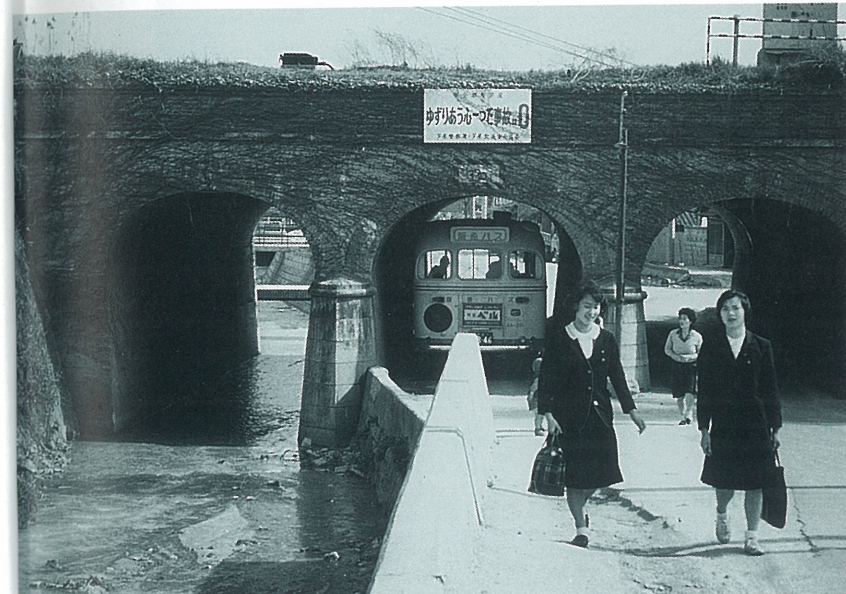
昭和41年ごろのめがね橋風景 宮川線国鉄北側から南を見る。
