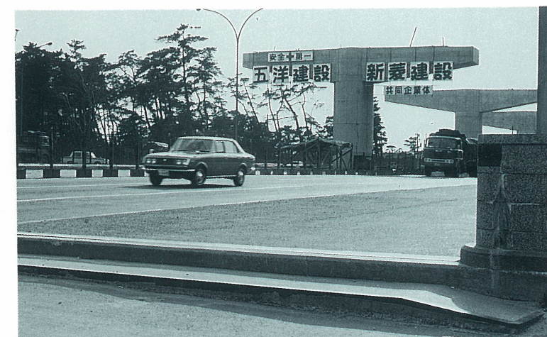
阪神高速道路建設工事 芦屋川付近
