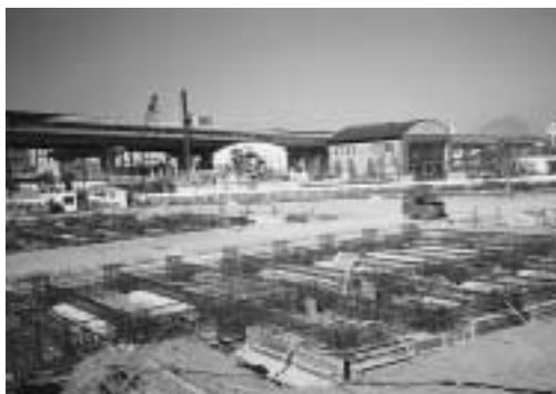
建設が進む総合公園
