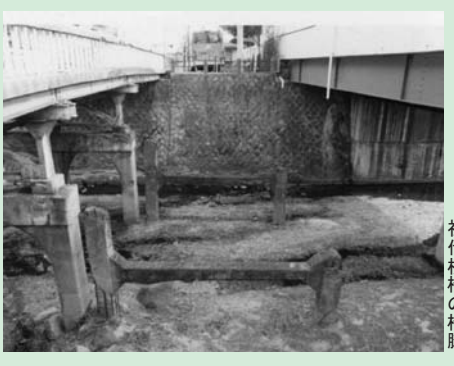
初代桜橋の橋脚
