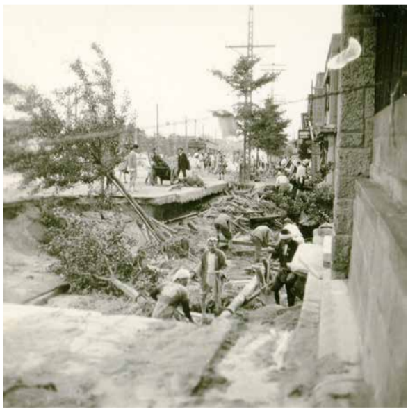
芦屋川が氾濫した阪神国道(国道2号)
