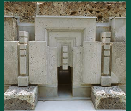
修理された外壁の飾り石
