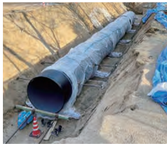
耐震性貯水槽設置工事(山手中学校)
