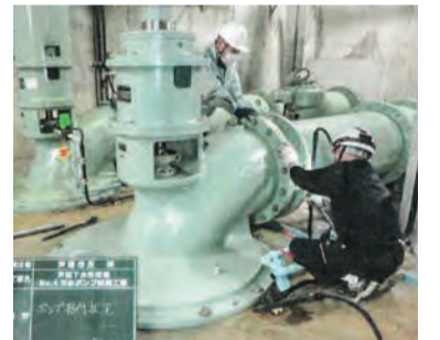
No.4 汚水ポンプ整備工事
