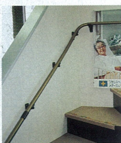
階段に手すりの設置
