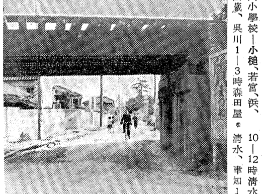
舗装工事中の道路
