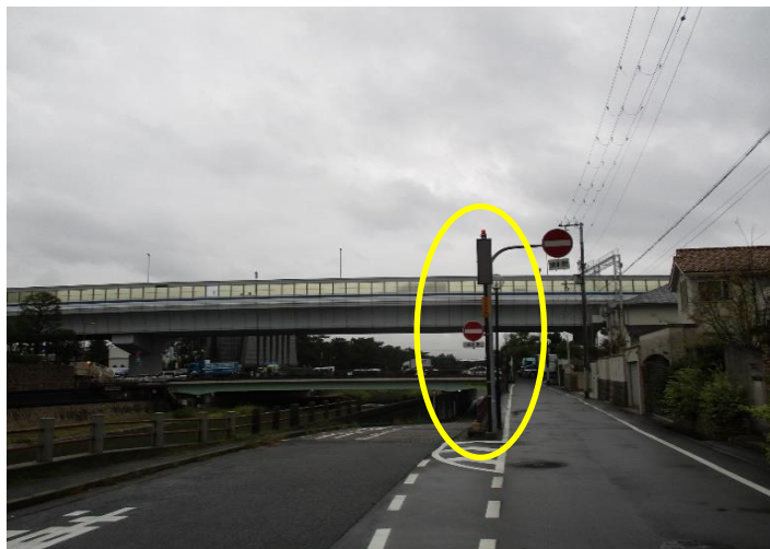
7番 アンダーパス手前の冠水表示板(山側)
