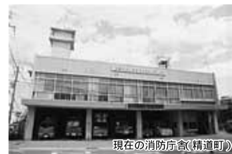
現在の消防庁舎(精道町)
