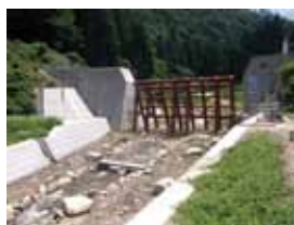
透過型砂防えん堤
