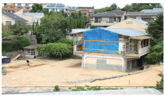
建て替え工事中の岩園幼稚園
