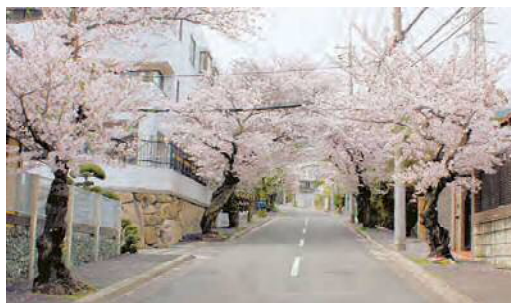
無電柱化が予定されている さくら参道
