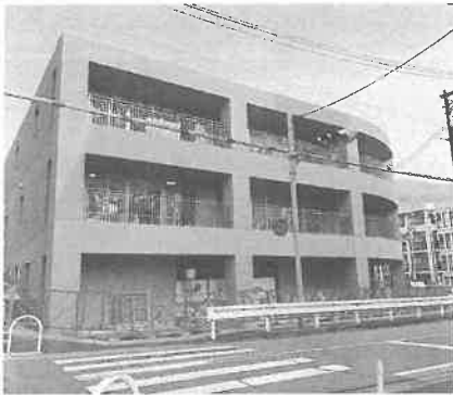
建設中の認定こども園
