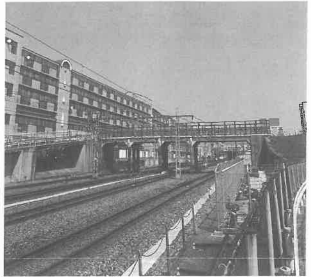
第一跨線橋（西側からの写真）
