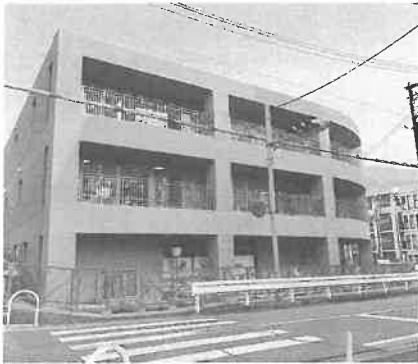
建設中の認定こども園
