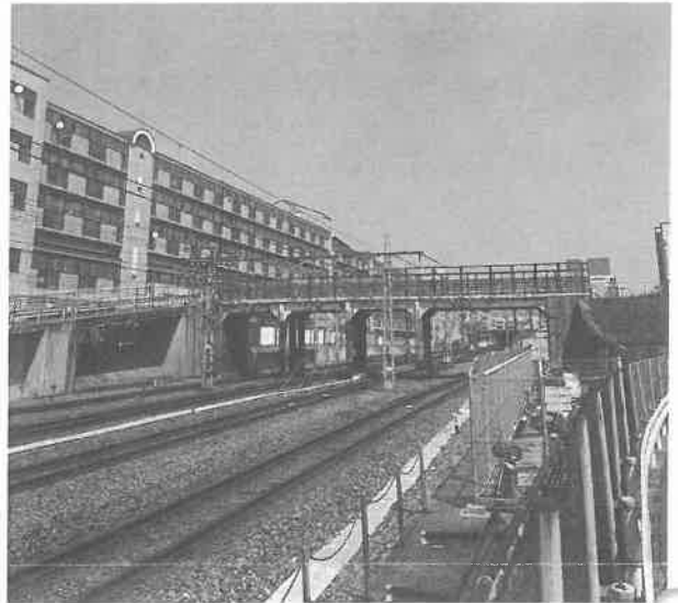
第一跨線橋（西側からの写真）
