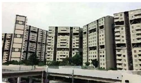
空き家対策が急務となっている芦屋浜高層住宅
