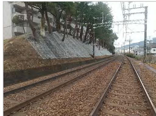
法面（線路南側）の様子
