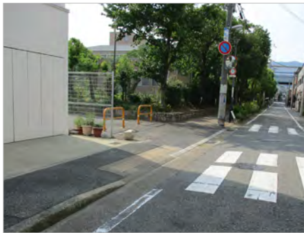
歩道の切下げ（改修前）
