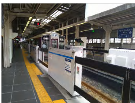
可動式ホーム柵の設置例
