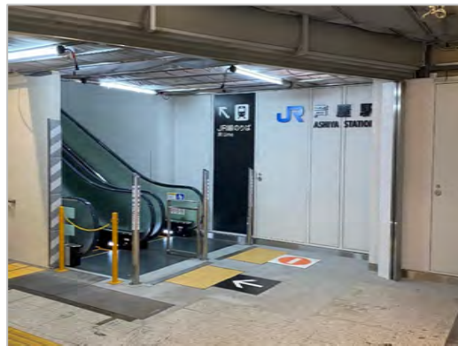
エスカレーター新設（柵外北側）
