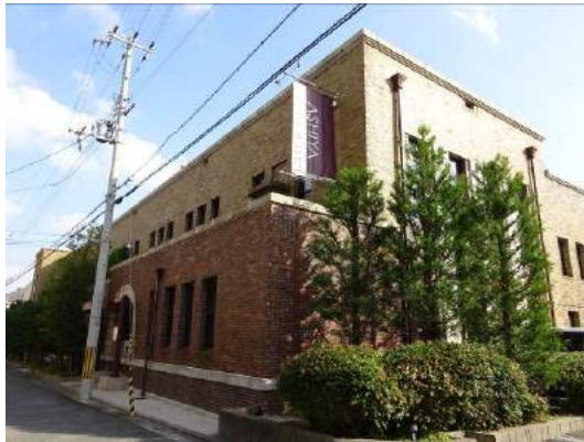
旧芦屋郵便局電話事務室 外観
