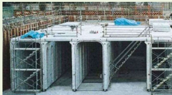
雨水貯留槽設置工事の参考写真
