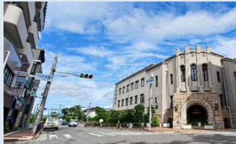
電柱抜柱後のイメージ
