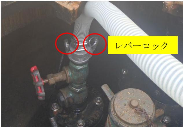
給水ホース（短い／太い）をマンホールの中にある給水口に差し込みます。
