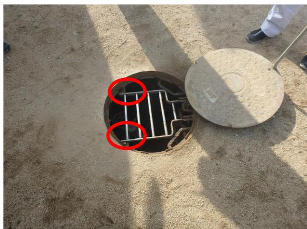
マンホールを開いたら、転落防止梯子がついているので、梯子の両側を同時に手前に引き持ち上げ、取り外します。
