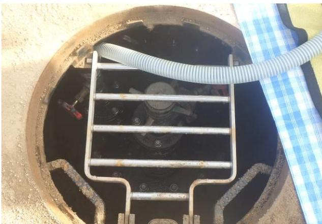
落下防止梯子を元に戻します。このとき、ロック状態になっているか必ず確認します。
