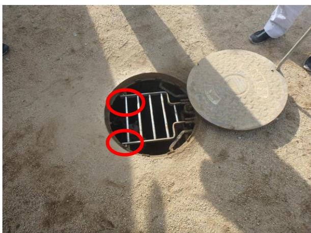
マンホールの転落防止梯子を取付け、マンホールを閉めます。
