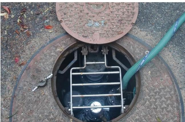
落下防止梯子を元に戻します。このとき、ロック状態になっているか必ず確認します。
