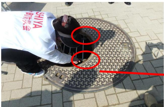
マンホールを開けたら、転落防止梯子がついているので、梯子の両側を同時に手前に引き持ち上げ、取り外します。
