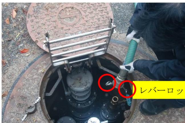
給水ホース（短い／太い）をマンホールの中にある給水口に差し込みます。
