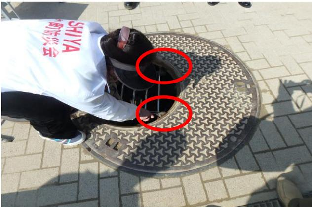
マンホールの転落防止梯子を取付け、マンホールを閉めます。
