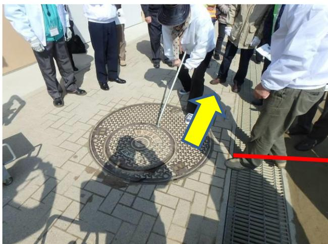
マンホール開閉バーを開閉用バー穴に挿入し、持ち上げて蓋を180度回し、マンホールを開けます。
