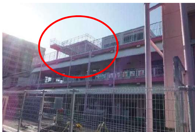
図 15 屋上への避難場所を増築した事例
