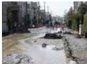
道路・宅地の被害
