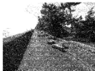
写真 4. 越波による植栽帯の被災状況
