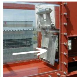
高潮時には海側からの水圧でゲートが閉まる
