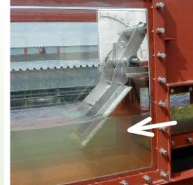
降雨時にはゲートが開き海に排水される
