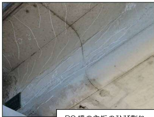
PC 橋の主桁のひび割れ
