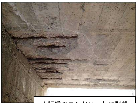
床版橋のコンクリートの剥離
