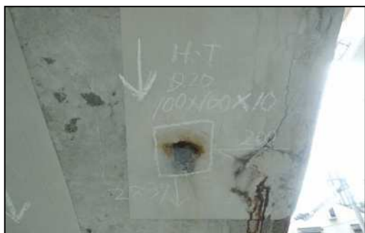
床版橋のコンクリートの剥離・鉄筋露出
