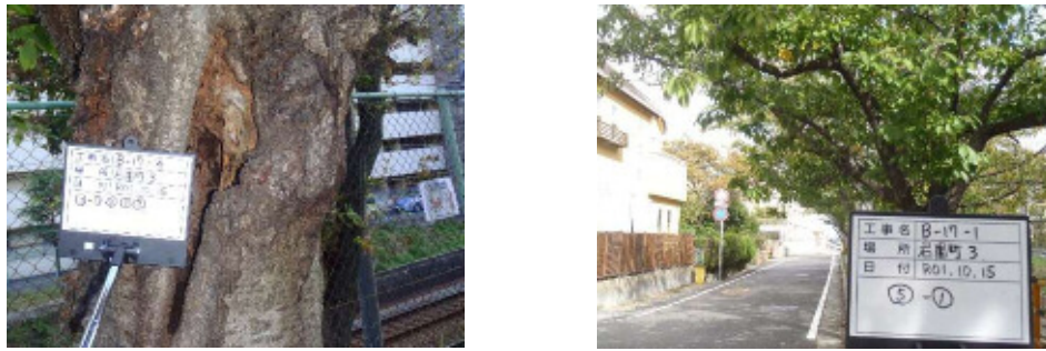
図 3-7 サクラの腐朽や建築限界侵害
