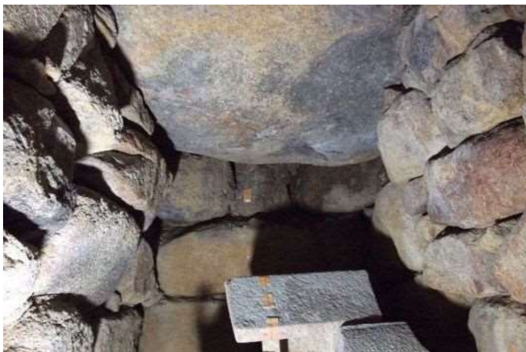
天井石と両側壁
