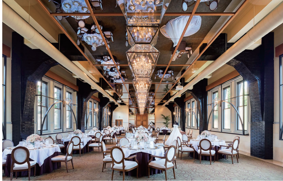
2階の旧自動機械室と旧手動交換室(現在のメインダイニング)。天井が5.4mと高く、また、機械や交換台を容易に配置できるよう、中間柱を設けず、10m間隔で梁が架けられた。
