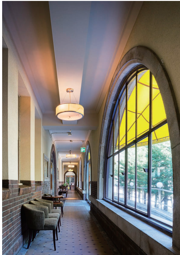
建物正面(北側)には連続アーチをもつ幅2mの側廊が設けられており、この建物のファサード(正面観)を特徴付ける。竣工当時にはサッシとガラスがなく、半屋外となっていた。
