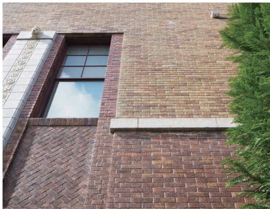
外壁は茶色系2色のスクラッチタイル張りで、濃い色を下に使うことで外観に落ち着きを与えている。
