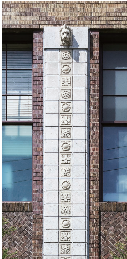
ししがしら 獅子頭とレリーフの装飾。建築当初は大谷石製 (p.8) だったが昭和61年(1986)の保存改修工事の際に焼物製に取り換えられた。
