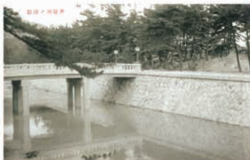
月若橋（昭和5年〔1930〕竣工）
