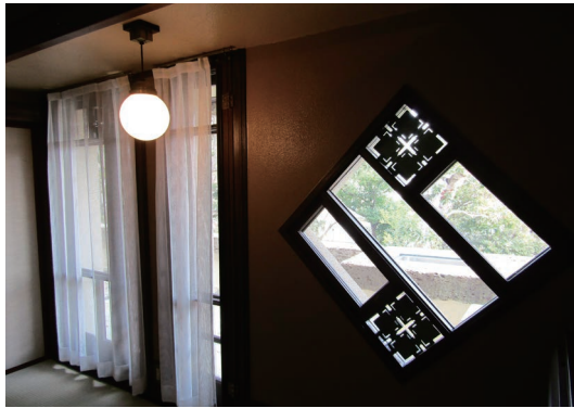
3階の8畳和室。45度傾け、飾り銅板 (p.12) が嵌め込まれた東側の窓。
