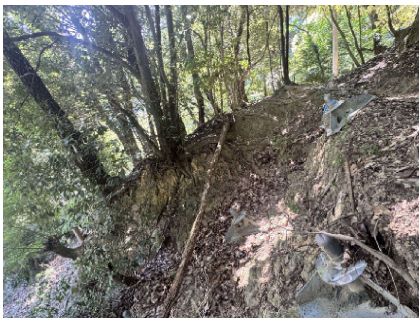
登山道① 土砂流出により斜面が削れ、道が痩せている。
