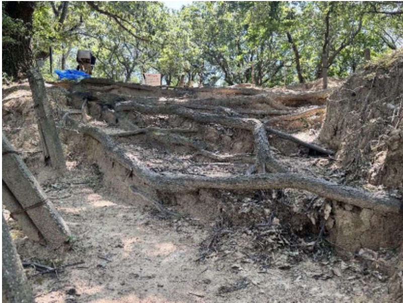
X・U地区間見学道 土砂流出により木の根が浮いている
