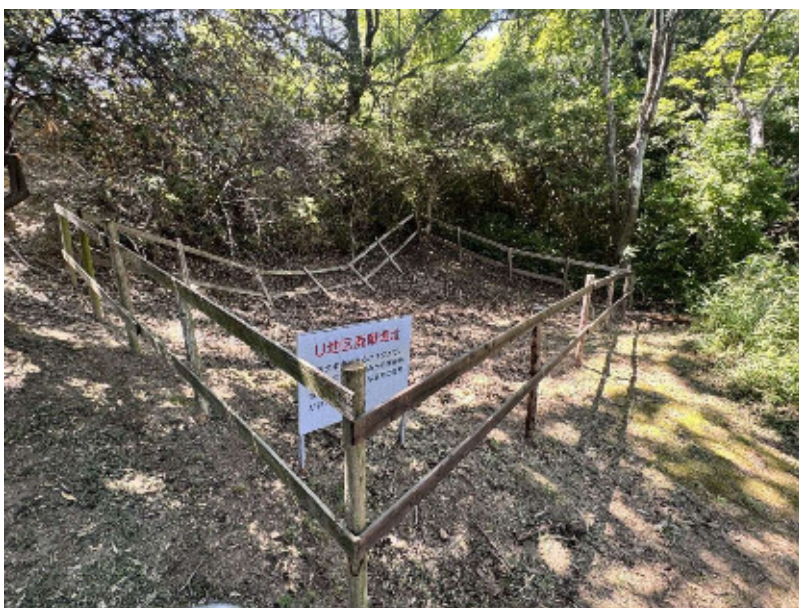
U地区廃棄場跡 近景 土砂流出により柵が倒壊している。
