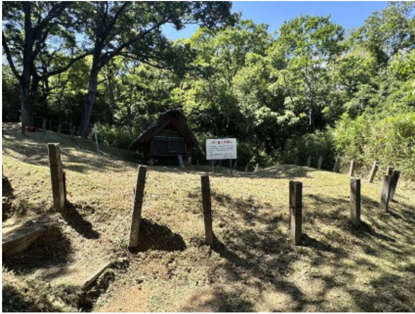
J 地区 近景 土砂流出により柵が浮いている。
