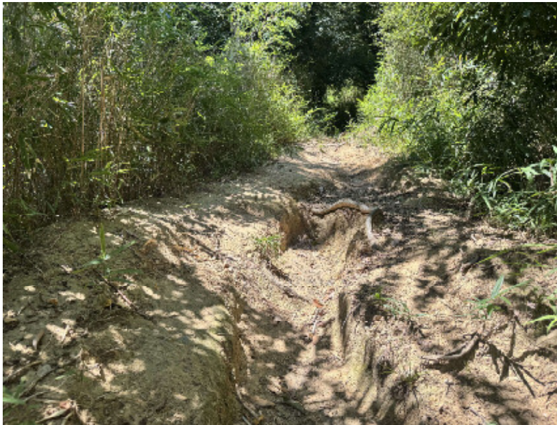
登山道⑤ 土砂流出により道が挟れている。
