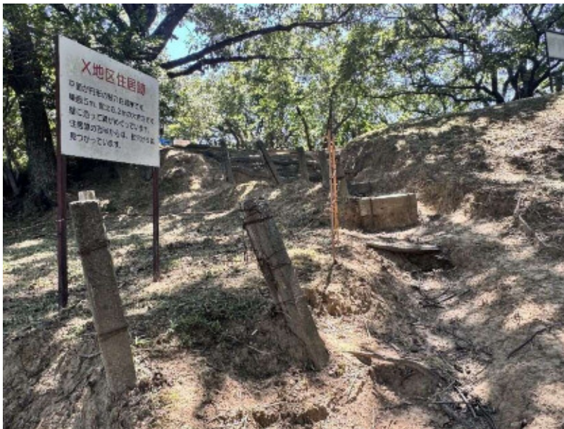
X地区竪穴住居跡そばの見学道 土砂が流出し、竪穴住居跡を囲む柵が倒壊している。
