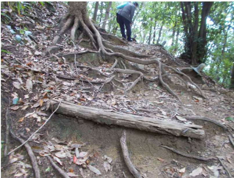
11 見学道 土砂流出により木の根が浮いている。 (地図地点：04)
