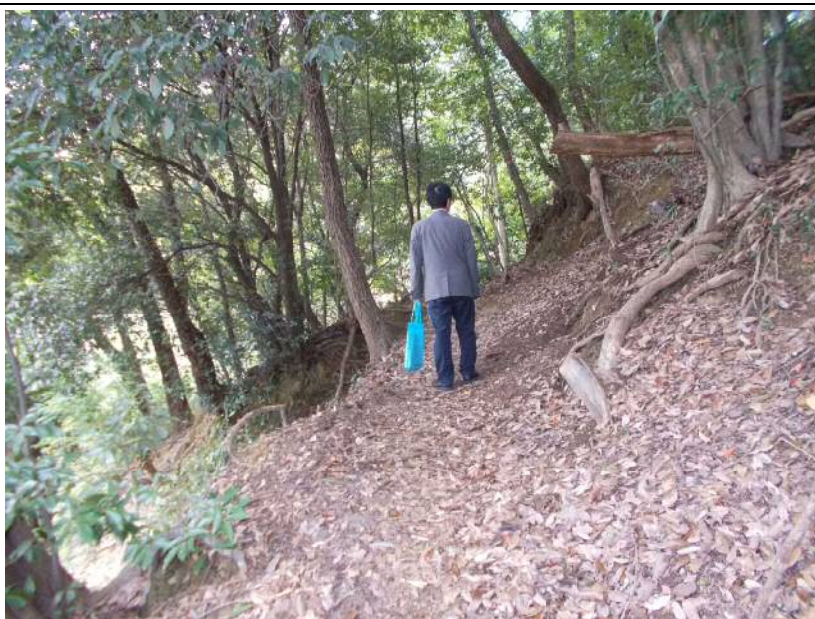
06 見学道 土砂流出により見学道がやせ細り、滑落の危険性がある。 (地図地点：02)
