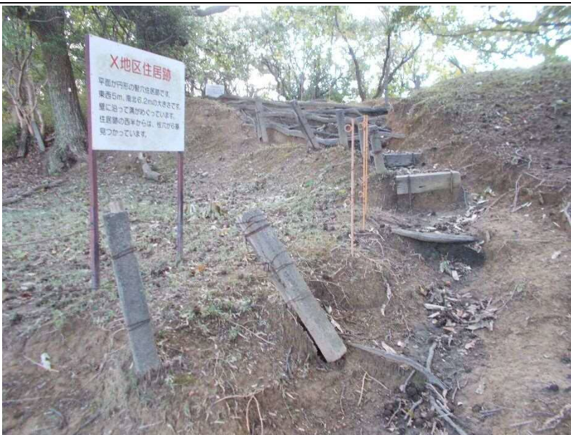
45 X地区北側見学道 土砂流出が著しく、踏板や柵 が浮いている。雨水の流れに よって水みちができ、見学道 が侵食されている。 (地図地点：16)
