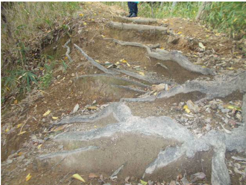
14 見学道 土砂流出により木の根が浮いている。 (地図地点：06)
