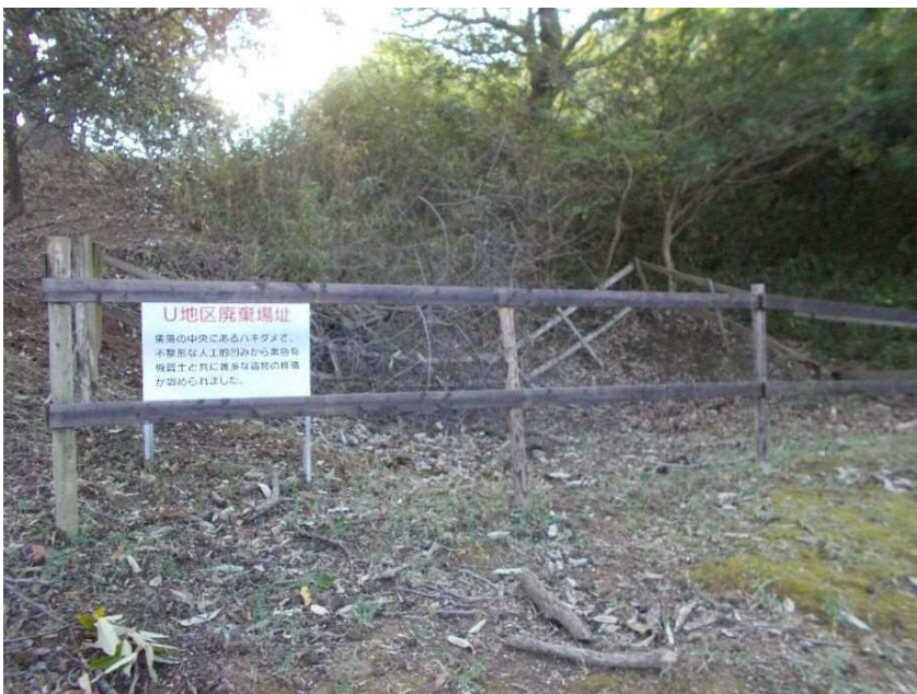
53 U地区遠景 土砂流出等により柵が壊れ、雨風による倒木が放置されている。
