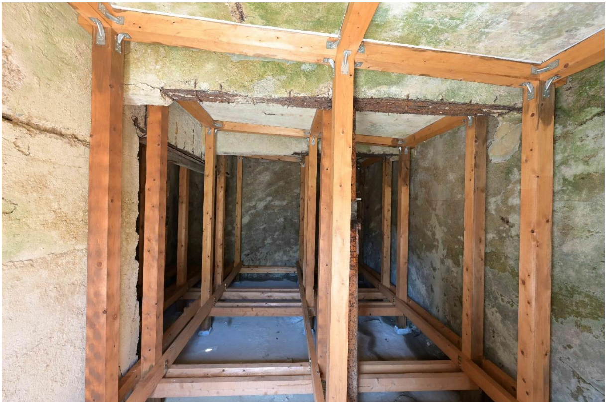
写真4 倉庫の内部（木部は応急構造補強）（東から）（『報告書』より）
