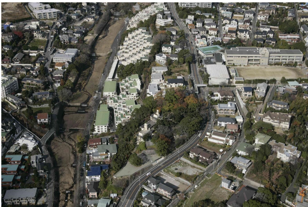
写真1 全景（南東から）（提供：淀川製鋼所提供）
